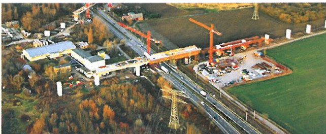
Baufortschritt der Saale-Elster-Talbrücke
