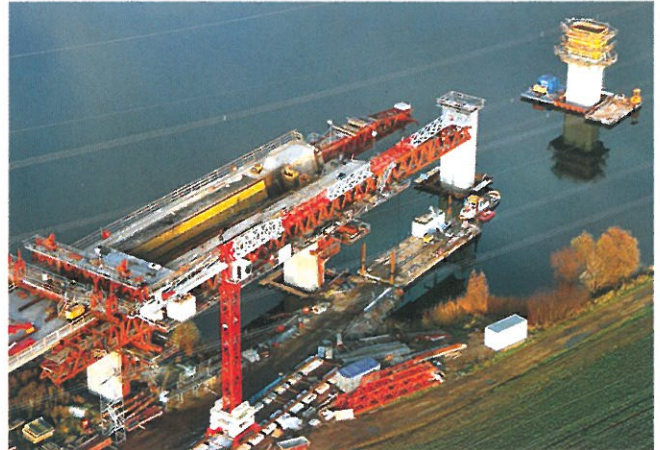
Baufortschritt der Saale-Elster-Talbrücke
