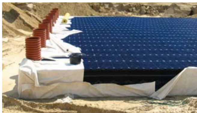
Moderne Versickerungselemente können das Regenwasser großflächig aufnehmen und schnell abführen.
