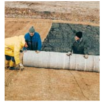
Erosionsschutzmatten bieten Böschungsoberflächen Schutz.
