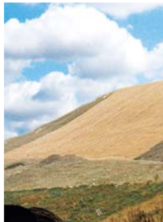
Erosionsschutzmatten bieten Böschungsoberflächen Schutz.
