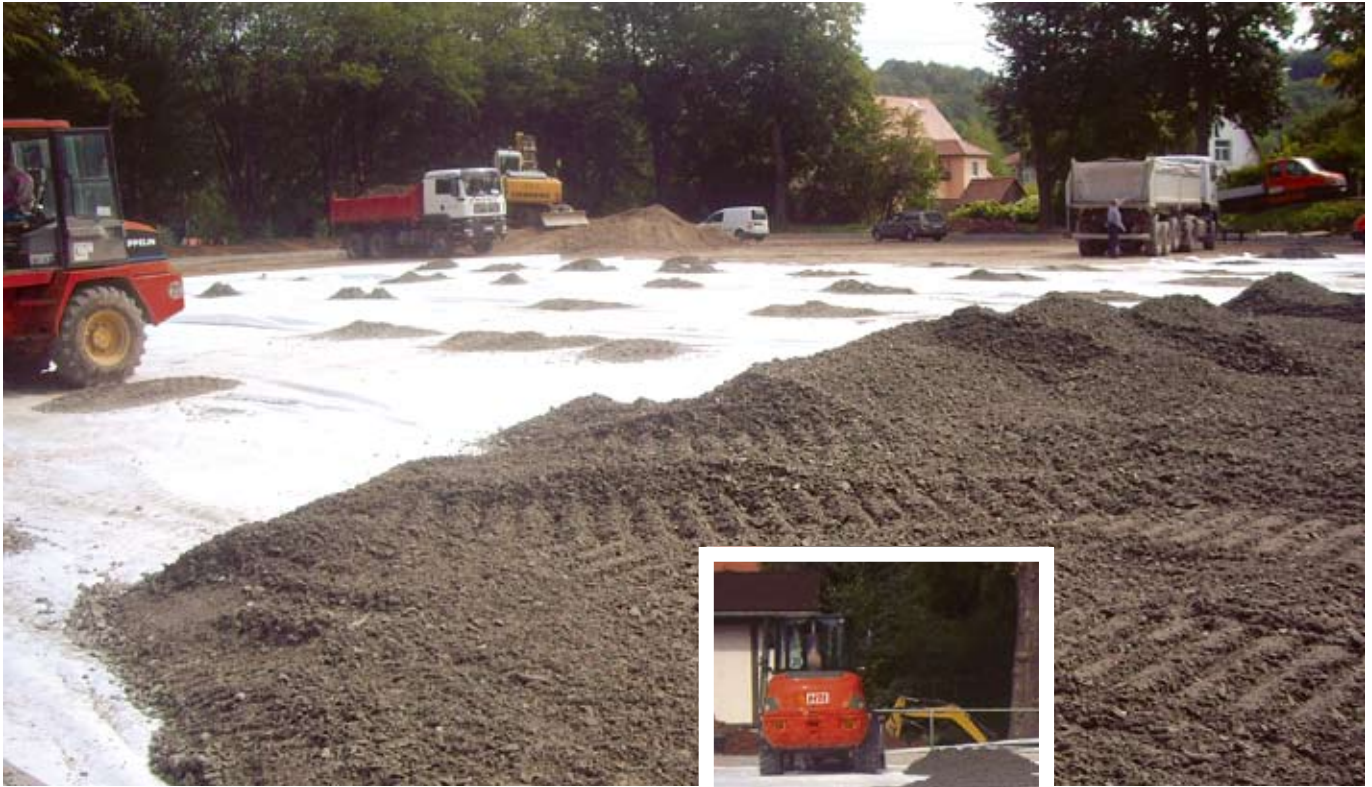
Geotextilvlies ist hoch belastbar und passt sich flexibel den Bodenverhältnissen an.
